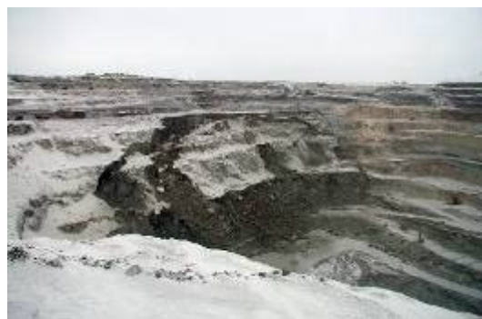
Рис.1. Фотография обрушенного участка борта карьера в мерзлых породах.
