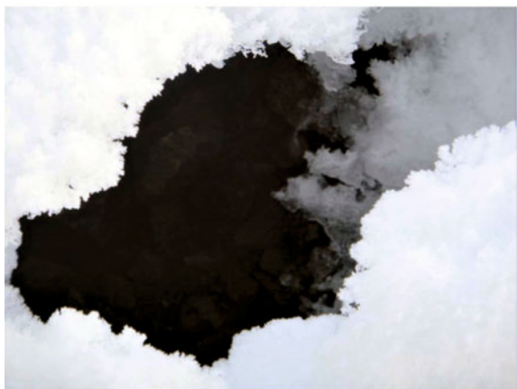
Рис. 5. ВГЭС-1,2. Тепловые отдушины на низовом откосе плотины (а) и возможные размеры выхода воздушного потока (б)
