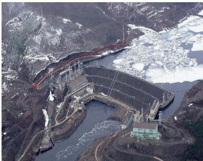
Рис. 1 Правобережное примыкание Вилуйской ГЭС
