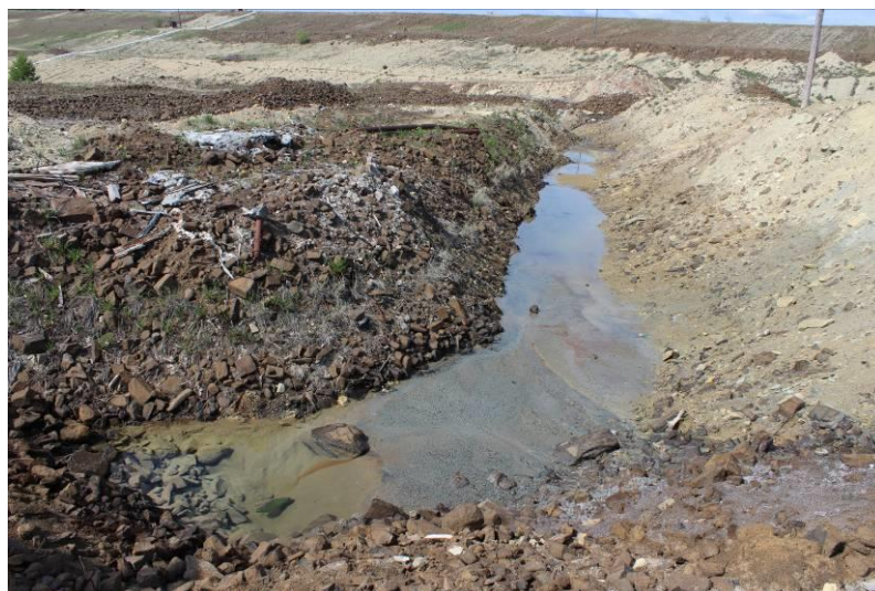
Рис. 3. Выход фильтрата в левобережной части нижнего бьефа накопителя.
